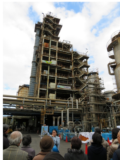
プラスチックリサイクルプラント
