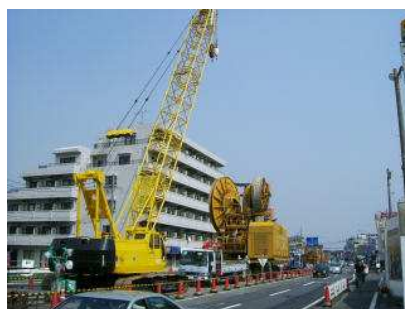
平成15年 工事中の地下鉄
