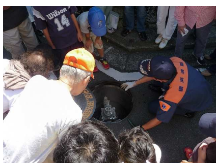
消火栓マンホール
